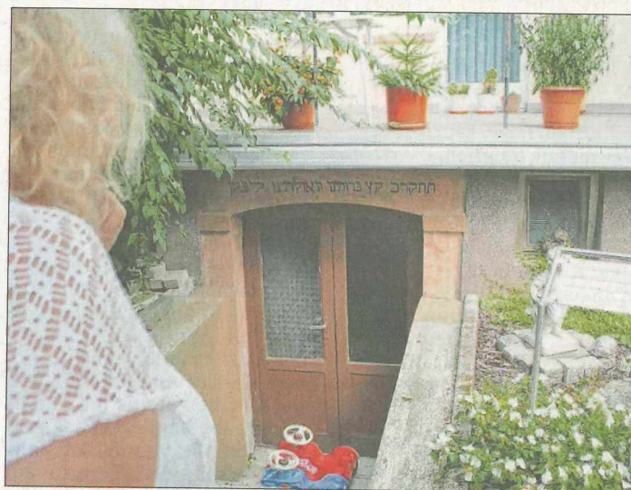
Die ehemalige Judenschule in der Diersburger Strittmatt. Das Gebäude ist noch zu besichtigen.
